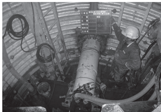
写真-4 ロックマンエース推進状況
